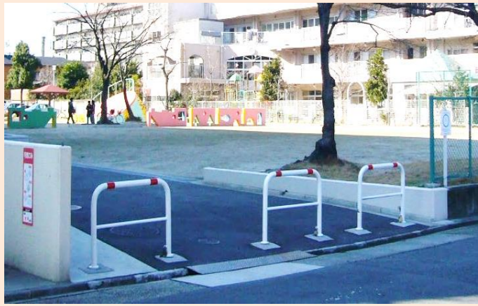
住宅の入口に 乗入禁止パイプ を設置することで車の出入りをなくし、安全を確保しました。
