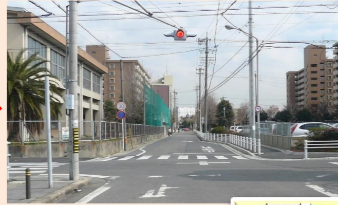
道幅が狭く、施行前の停止線の位置だと対向車と正面衝突する危険があったので、住宅都市局・土木局・国に危険性を訴え、花壇を撤去して市営住宅の土地を道路に譲り渡してもらい、左折車線を 一車線拡幅 し、安全にすれ違えるようになりました。
