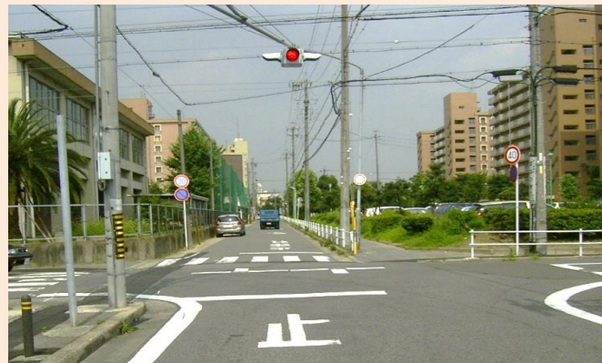
道幅が狭く、施行前の停止線の位置だと対向車と正面衝突する危険があったので、住宅都市局・土木局・国に危険性を訴え、花壇を撤去して市営住宅の土地を道路に譲り渡してもらい、左折車線を 一車線拡幅 し、安全にすれ違えるようになりました。
