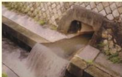
雨天時の合流式下水道の吐き口
