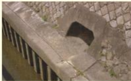
晴天時の合流式下水道の吐き口
