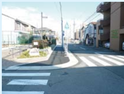
U字側溝を取り除き歩きやすい歩道にしました(元塩町3丁目)
