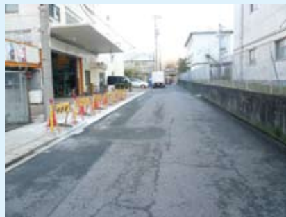
一般のL型側溝を大型車両の重量に耐えうる施工にしました。(元塩町1丁目)
